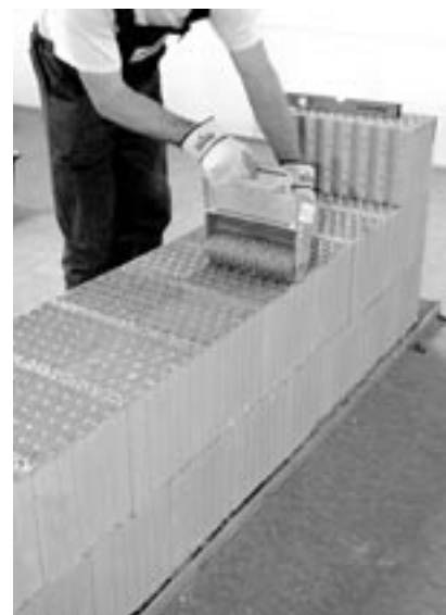
Obr. 10-4 Nanášení malty válcem
