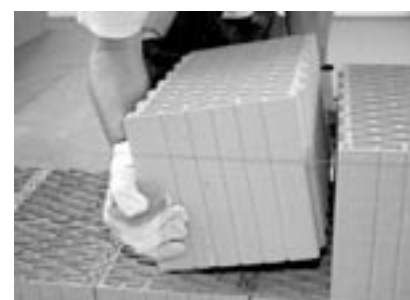
Obr. 10-3 Zdění z broušených cihel
