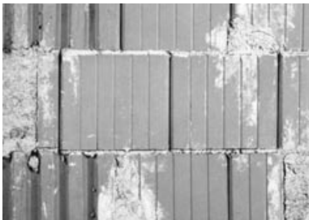
Obr. 11-4 Vyspravení povrchu zdiva před omítáním
