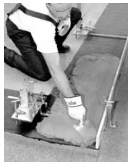
Obr. 10-2 Příprava první vrstvy malty
