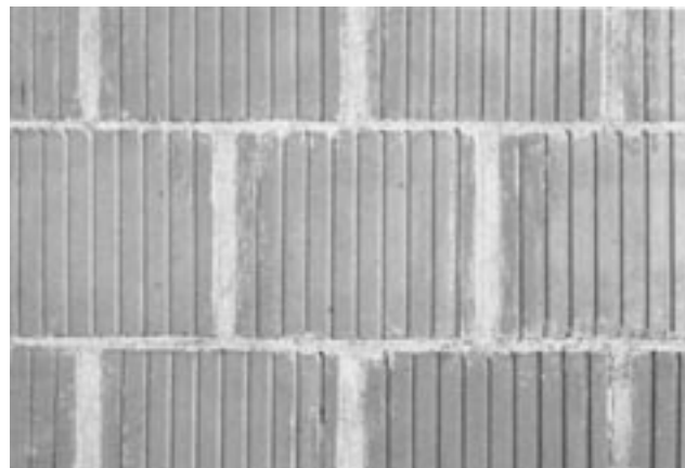
Obr. 20-1 Zdivo s viditelně promaltovanými styčnými spárami
